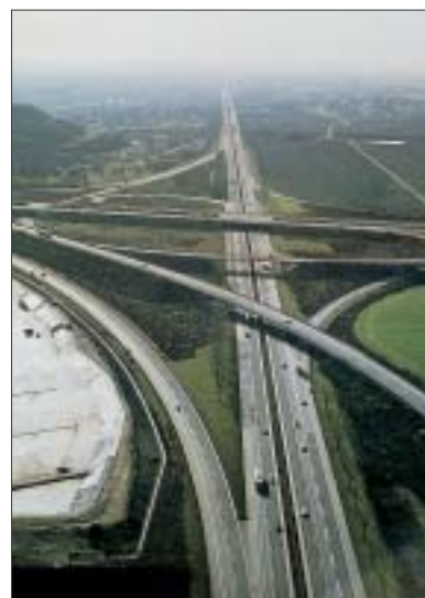
Münchens nördlicher Erschließungskorridor, bestehend aus der Autobahn A9 und der oberirdische U-Bahnlinie 6, durchschneidet Freimann in der Mitte - bis heute ohne Lärmschutz.
