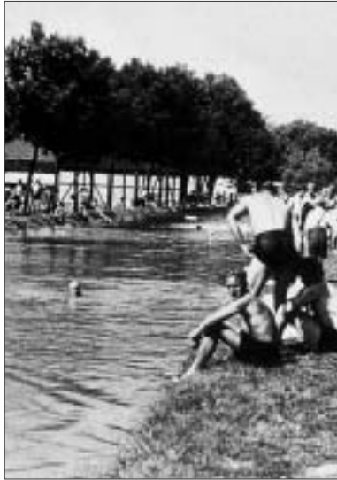
Ein großer Anziehungspunkt für München und Freimann war das Familienbad Floriansmühle, das 1932 errichtet und in den 50er Jahren weiter ausgebaut wurde. In den 80er Jahren wurde es für die Öffentlichkeit geschlossen.
